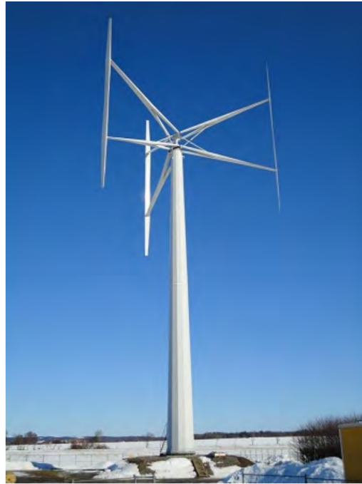
Figura 1.5: Turbina eolica H-type prodotta da Vertical Wind AB
